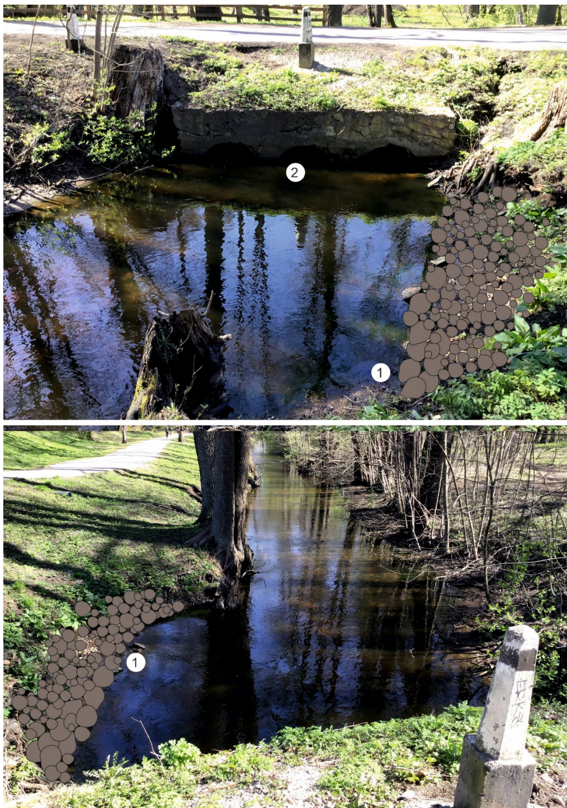
Attēls 21. Mārupītes gultnes dažādošana posmā lepus Codes ielas šķērsojuma. 1- nogāzes pamatni nostiprina ar šķembu vai rupju oļu klājumu; 2- caurteku atbrīvo no aizsērējuma. Foto: L. Urtāne, zīm.: A.V.Urtāns.
