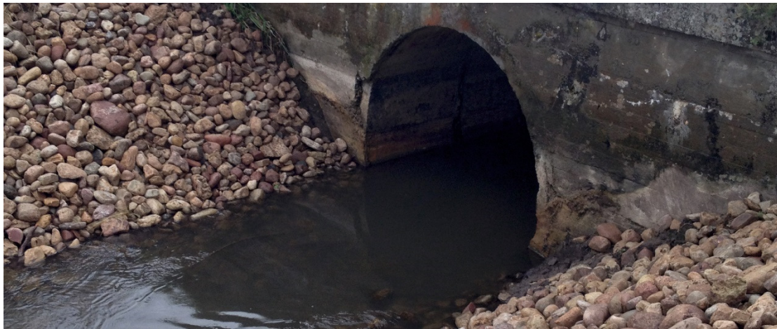
Attēls 18. Krastu stiprināšanai izmantotais nesaistītu akmeņu materiāls krasta–ūdens saskares zonā kļūst par akmeņaino dzīvotņu apdzīvojošo ūdens organismu uzturēšanās un zivju barošanās vietām. Foto: L. Urtāne.
