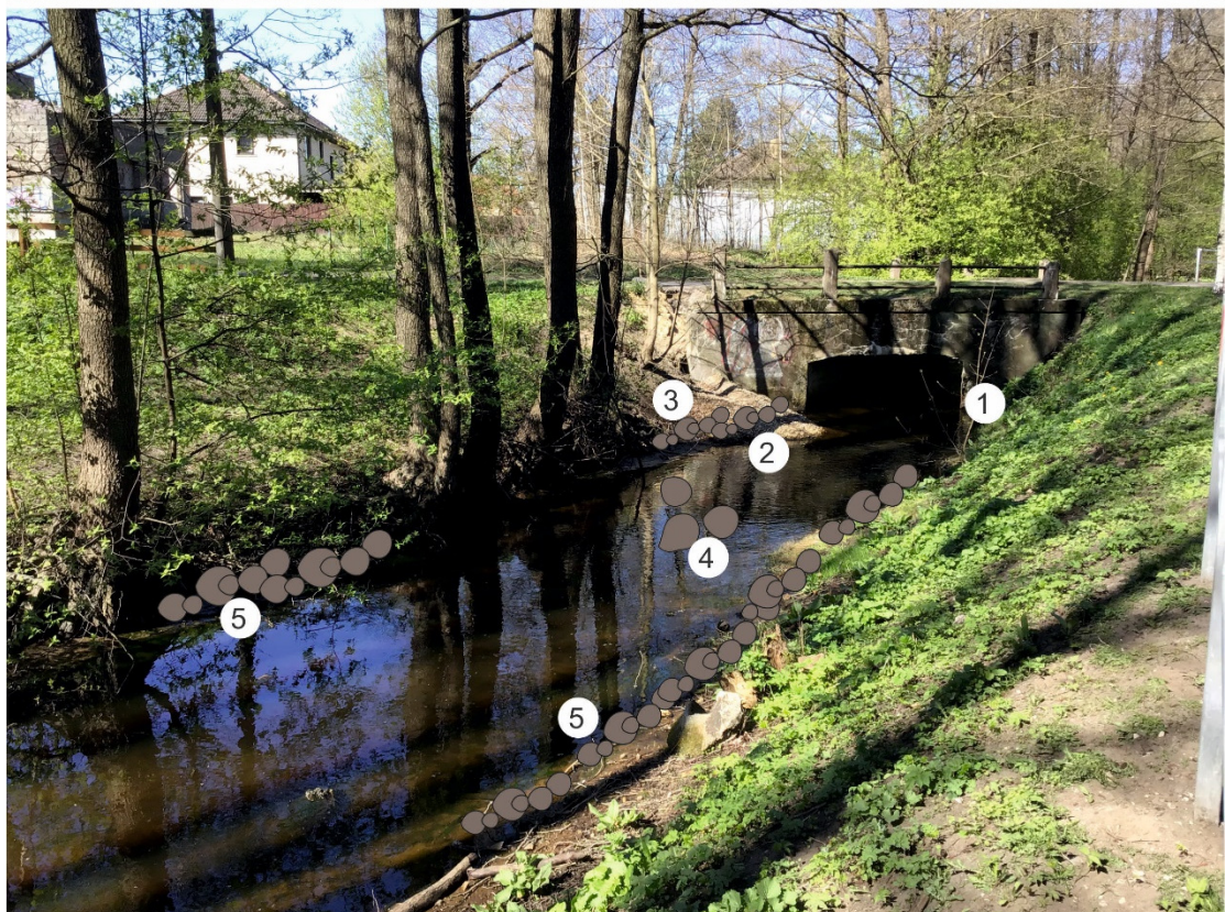
Attēls 19. Mārupītes gultnes dažādošana posmā lejpus Brūkļu ielas šķērsojumam. 1- nostiprina izdrupušo tilta konstrukciju; 2- norok nobirumu, kurš kavē caurteci; 3- izvieta akmeņu rindu; 4- gultnē ievieto akmeņu grupu, kura pastiprinās aerāciju; 5- nogāzes pamatni nostiprina ar šķembu vai rupju oļu klājumu. Foto: L. Urtāne, zīm.: A.V.Urtāns.
