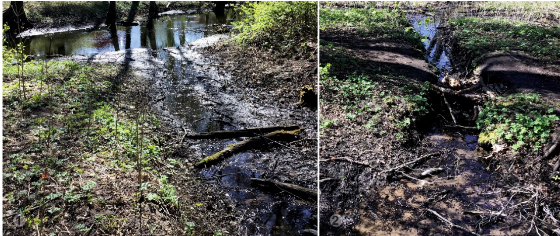
Attēls 17. Dabiskās notekas uz upi ir pilnīgi vai daļēji aizsērējušas ar nobirušo lapu un dūņu slāni (1). Vietām tās aizsprostotas stihiski veidojot pārejas (2). Foto: L. Urtāne.
