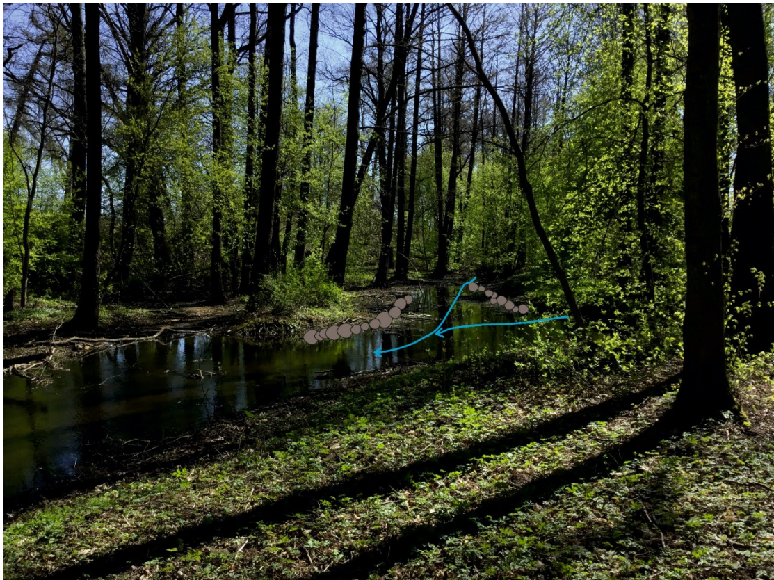
Attēls 22. Gultnes dažādošana Bierīņgrāvja un Mārupītes satekas vietā. Akmeņi izvietoti tā, lai sašaurinātu Bierīņgrāvja gultni un straumi novītzītu no melnalkšņu saknēm. Foto: L. Urtāne, zīm.: A.V.Urtāns.
