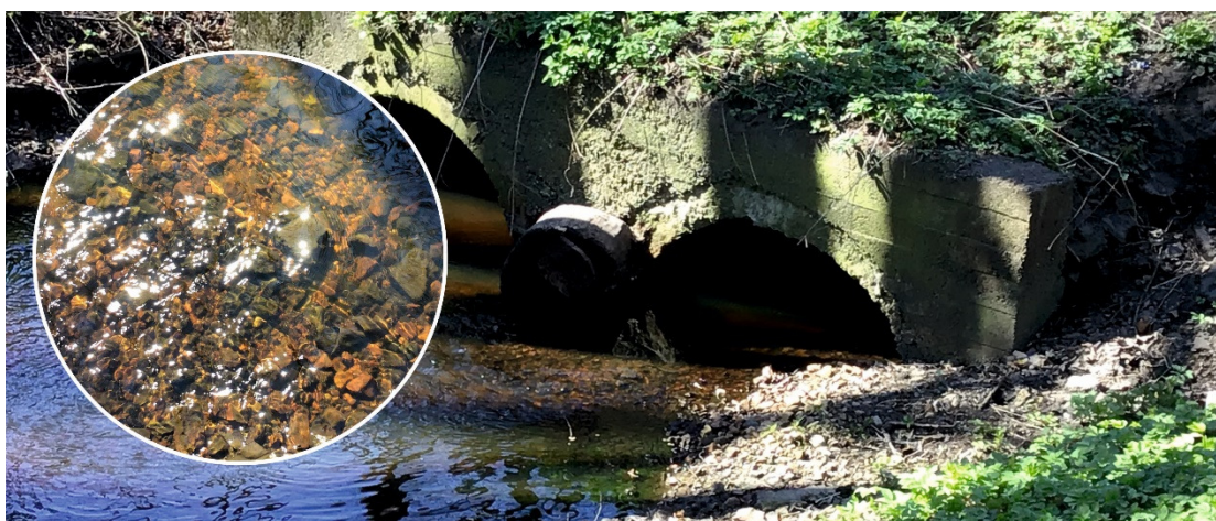
Attēls 6. Ceļa šķērsojuma vietā gultni veido caurtekas stiprināšanai izmantotais akmens šķembu materiāls. Foto: L. Urtāne.
